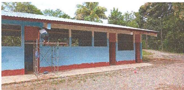
Foto 3: se observa el avance del mantenimiento de los balcones.
