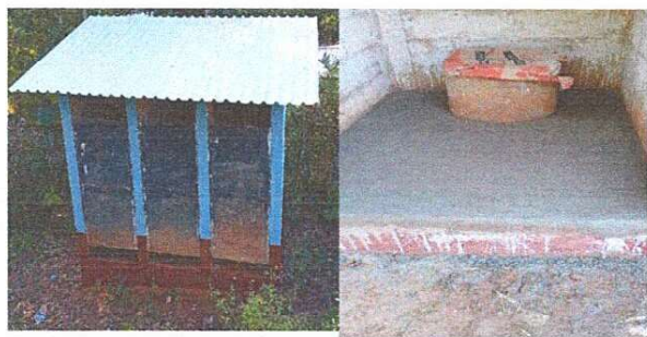
Foto 5: se observa el avance del mantenimiento de los baños.
