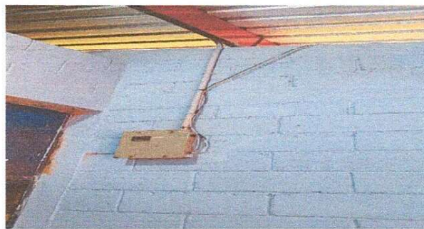
Foto 2: Se observa el avance de las instalaciones electricas.
